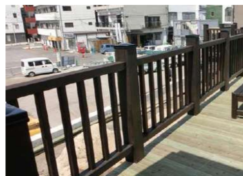
固形木材防腐剤 (インペルロッド) 打込の上銅板巻を 施す
