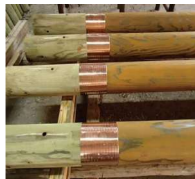
固形木材防腐剤 (インペルロッド) 打込の上銅板巻を 施す
