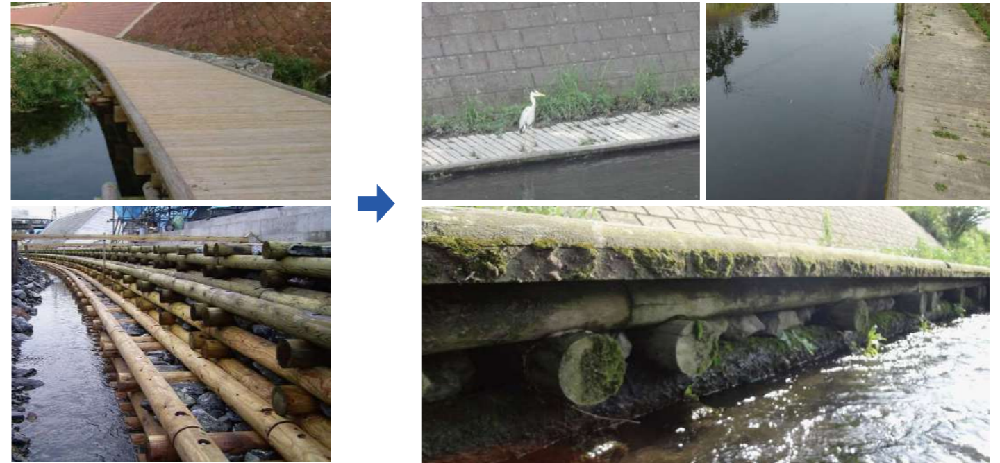
銅板又は樹脂キャ ップの使用 または 滞水しない形状加工 (球面加工等)
